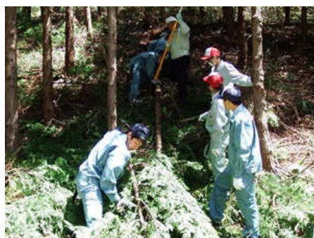
松川入植樹作業（間伐）
